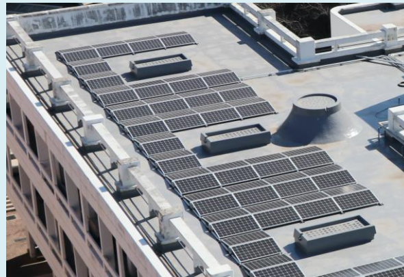
3号館屋上(パネルは東西向き傾斜10度)
